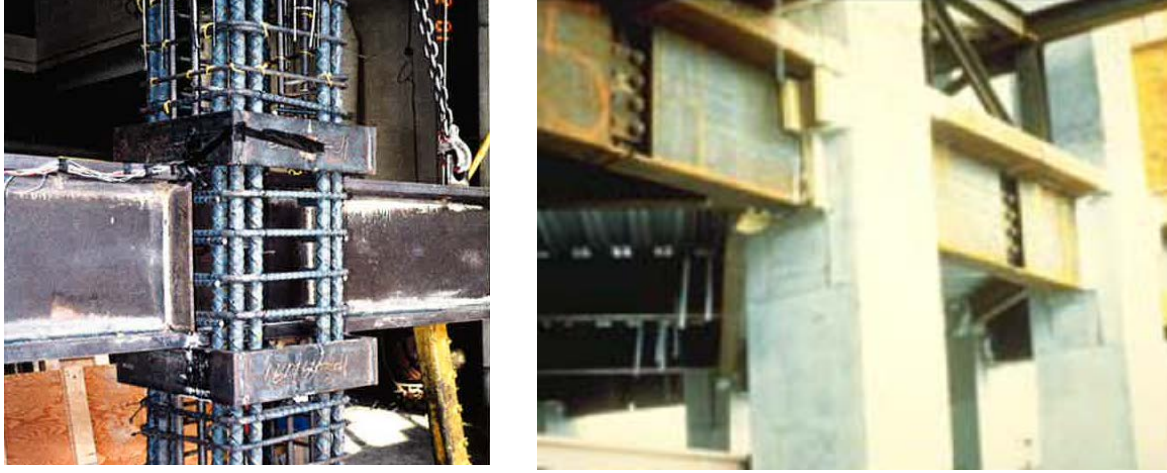
Şekil 2. Tipik bir BAÇ düğümündeki çelik bileşenler (solda) [4] ve tipik bir BAÇ düğümü (sağda) [2]
